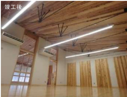
図4:CLTを使った張弦梁による屋根（高知県立林業大学校）
