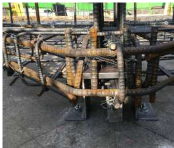
柱脚アンカーフレーム
