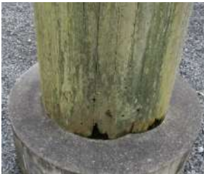
図10：木口からの腐朽
